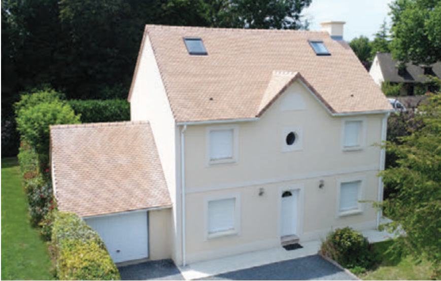
Private house, Caen Guard Wash® Express auf Terrassen, Fassaden und Dächern
